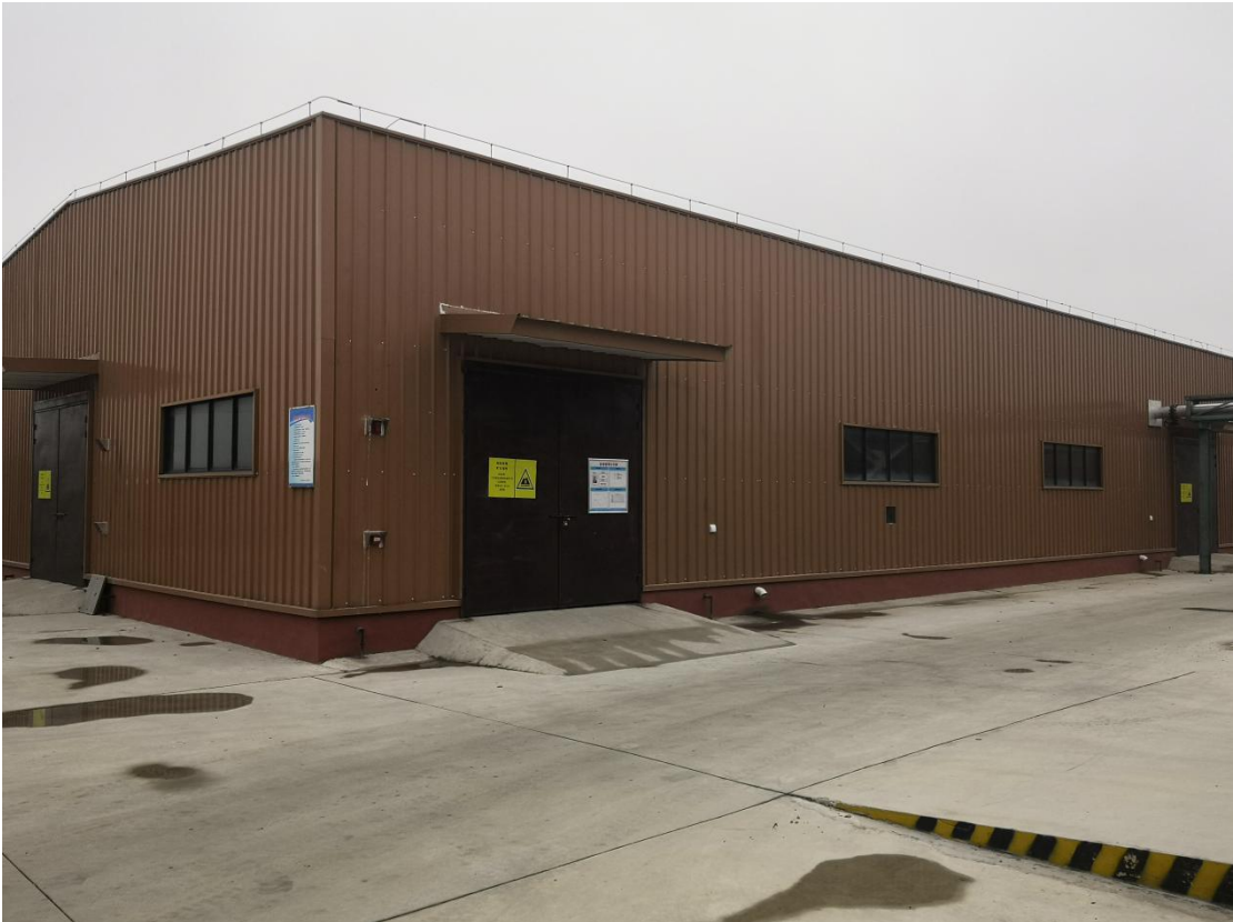
图 4-1 危废储存仓库现场图片
