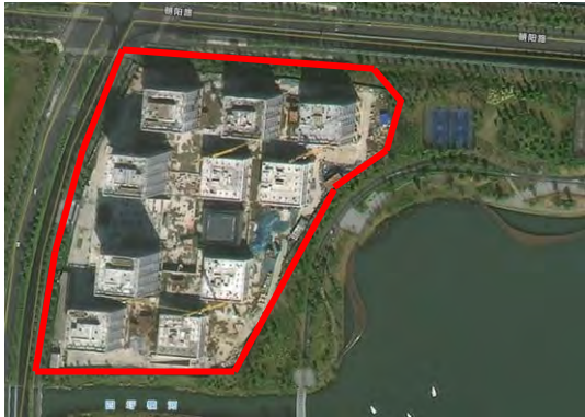
图 2-12 施工中遥感影像（2021.3）
