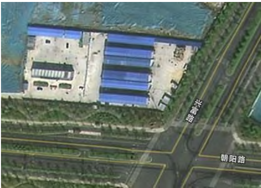
图 2-13 项目施工生产生活区（2020.10）
